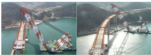
(e) SBL-03 (P3~4) 설치 (f) 강교 설치 완료
