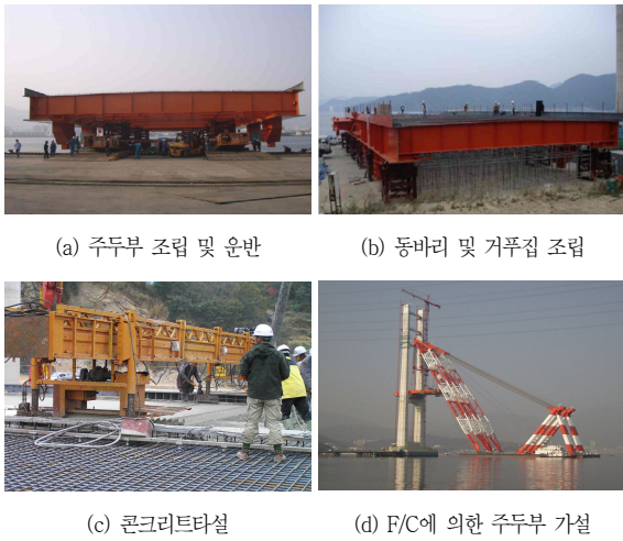
그림 23. F/C에 의한 주탑 주두부 비대칭 가설 전경
