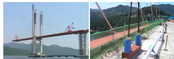
(a) 내풍 케이블 설치 전경 (b) 내풍 케이블 긴장 정착구
