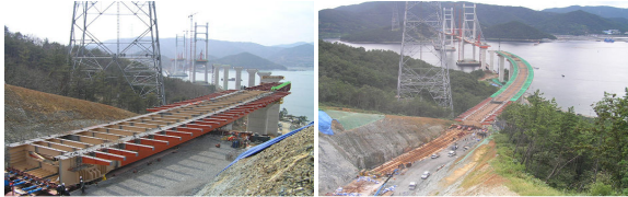
(c) 브라켓 설치
