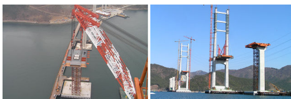
(a) 피어테이블 설치 (b) 피어테이블 설치 완료
