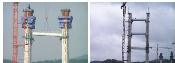
(a) 1단 스트럿 설치 (b) 2단, 3단 스트럿 설치 완료
