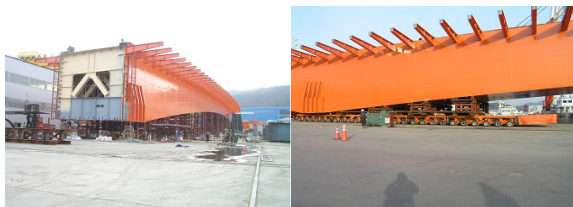
(a) 대블럭 지조립 (b) Transporter를 이용한 강교 운반
