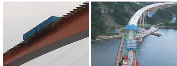
(b) Ballast wagon (c) 슬래브 타설 전경
