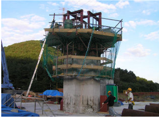
그림 20. Mock-up test 전경
