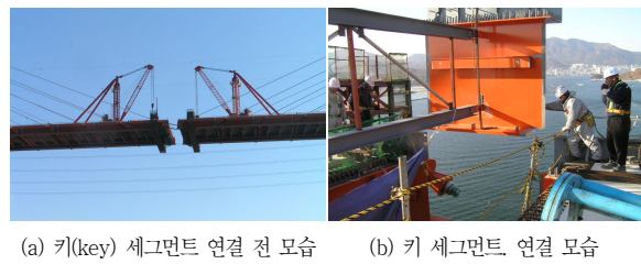
그림 25. 주경간 키 세그먼트 연결 전경
