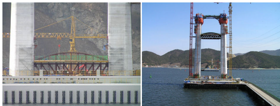
(a) 가로보 제작용 트러스거더 (b) 트러스의 heavy lifting
