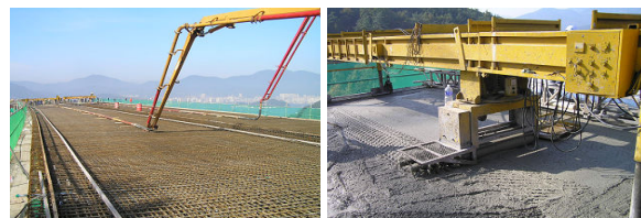
(e) 상부 슬래브 철근 조립
