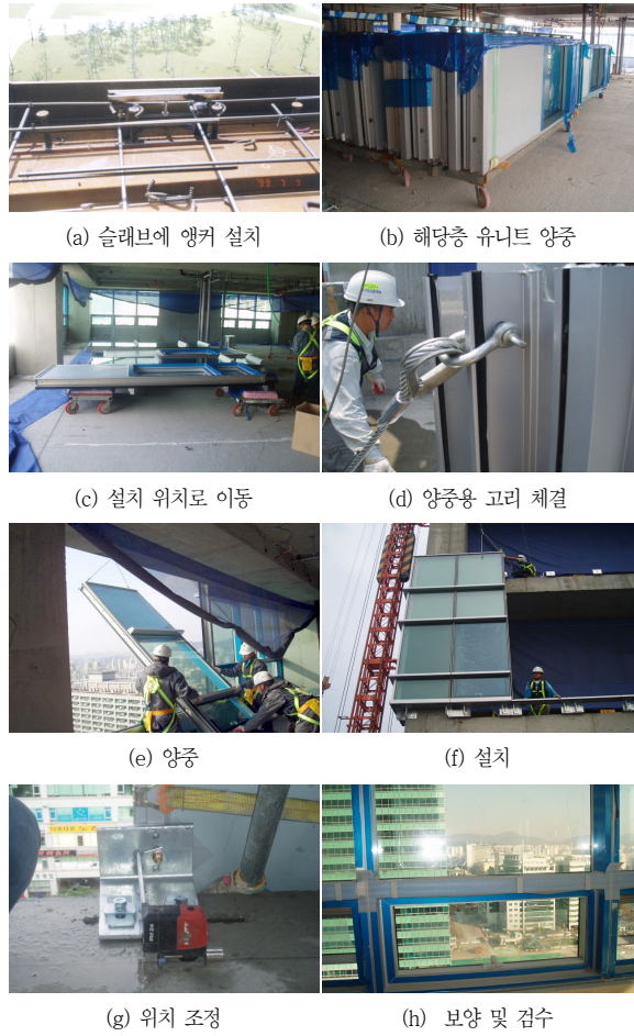
그림 14. 외부 커튼월 설치 과정
