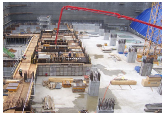
(b) 벽체 콘크리트 타설
