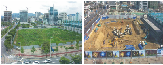
(a) 공사전 대지 형상 (b) 흙막이 공사 및 타파기 작업
