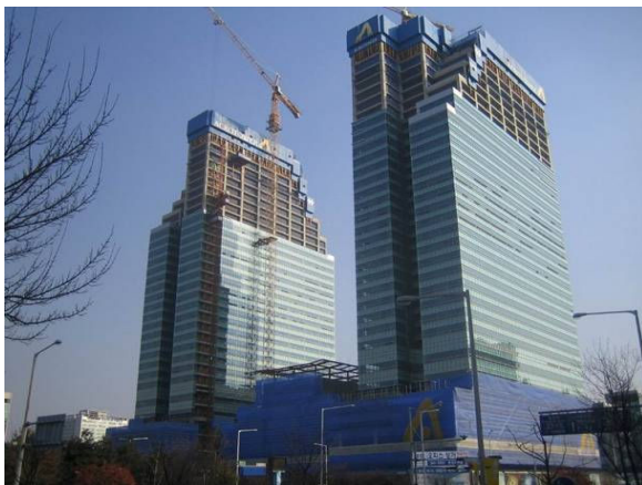
그림 13. 외부 커튼월 설치 장면
