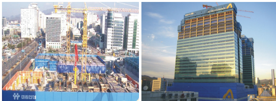
(e) 저층부 골조 공사 (f) 골조 및 C/W 공사
