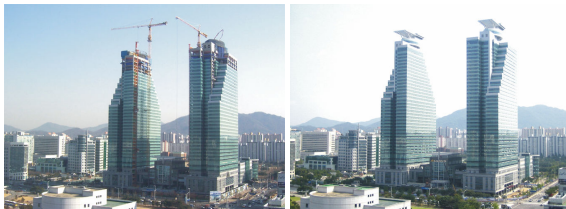
(g) 최상층 골조 및 외부 마감 공사 (h) 고층부 골조 및 외부 마감 공사
