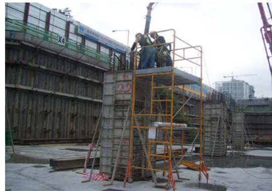
(a) 기둥 콘크리트 타설
