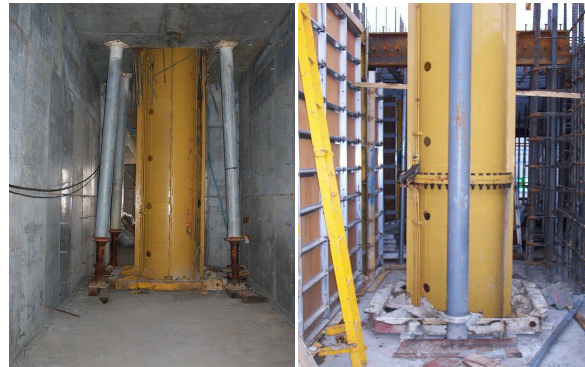
그림 12. CPB 장비의 현장 설치 장면(슬래브 고정 방식)
