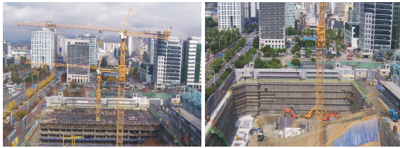
(c) 흙막이 및 지하 타파기 공사 (d) 지하층부 골조 공사
