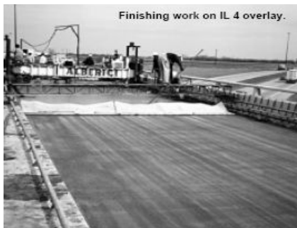
그림 1. IL 4번 노선의 교면포장 시공
