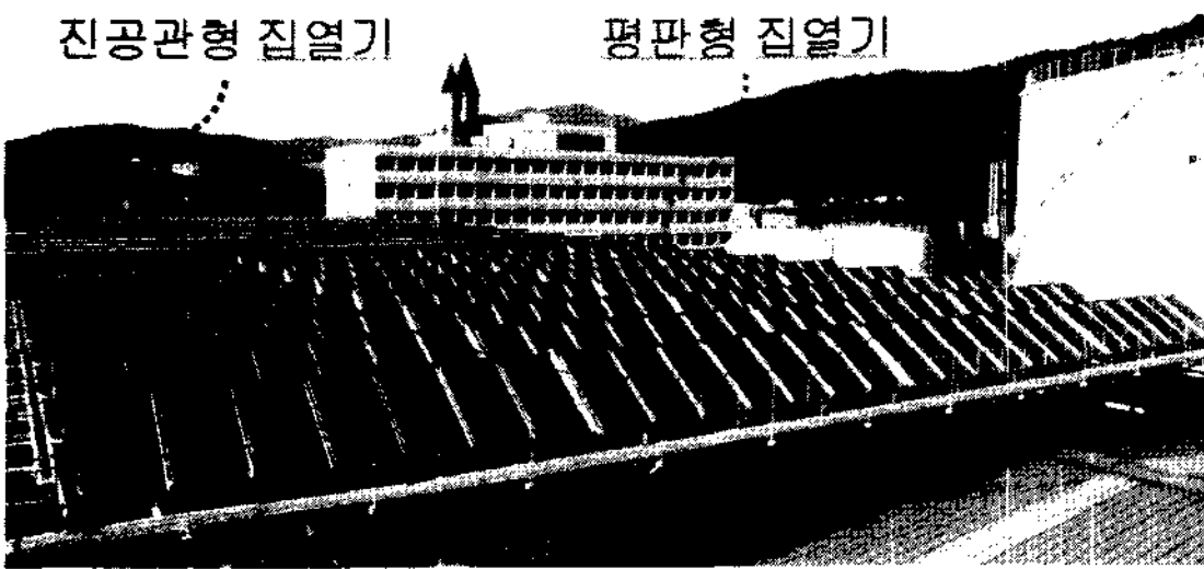
[그림 1] 지역난방용 태양열시스템 집열기 설치 전경
