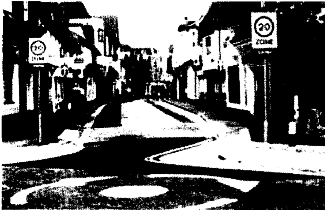
〈사진 2〉 유럽의 정비된 국지도로의 전경 (존20 표지판과 pinch point, 험프, 이미지 미니 로타리 등으로 정비되어 있다.)
