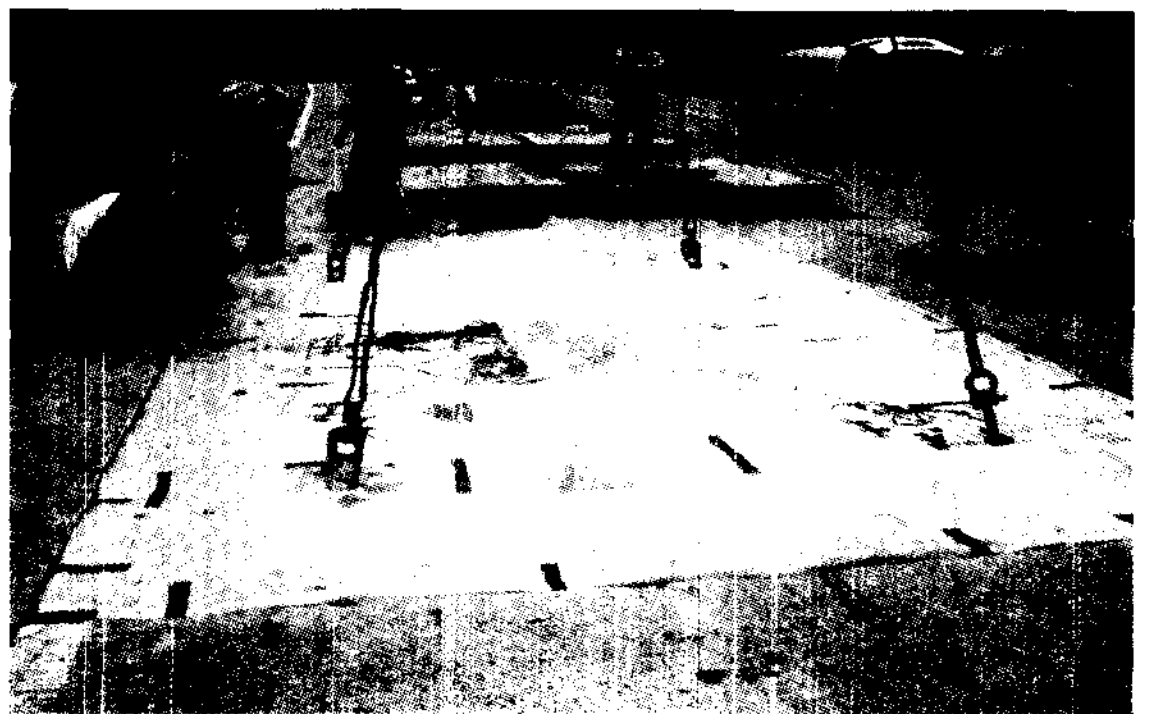
그림 10. 슬래브 안착 작업
