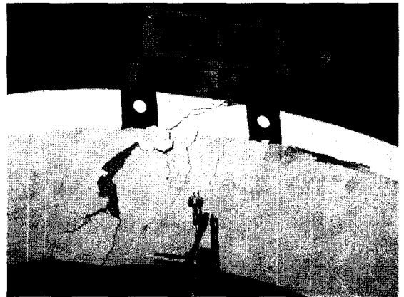
그림 17. 단순 프리캐스트 아치세그먼트 파괴 전경
