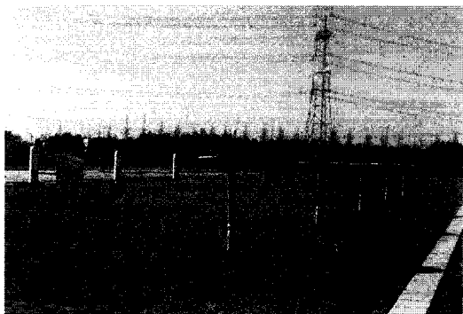
그림 7 직류 시험선로에 설치된 대전체 Fig. 7 Charged bodies installed at the DC test line
