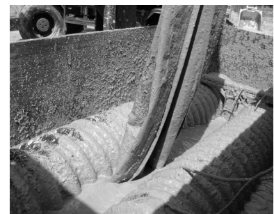
그림 5. 계측기 설치 및 유동성 뒷채움재 타설(좌측 : LVDT 설치, 가운데 : 토압계 설치, 우측 : 타설)
