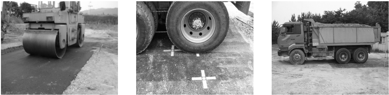
그림 6. 시공장면(좌측 : 아스팔트 포장, 가운데 : 재하차량, 우측 : 하중재하)
