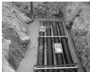
그림 5. 계측기 설치 및 유동성 뒷채움재 타설(좌측 : LVDT 설치, 가운데 : 토압계 설치, 우측 : 타설)
