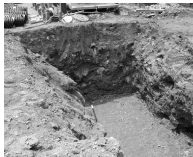
그림 4. 관로 시공(좌측 : 실험단면도, 가운데 : 관로굴착, 우측 : 유동성 뒷채움재 부력지지용 앵커)
