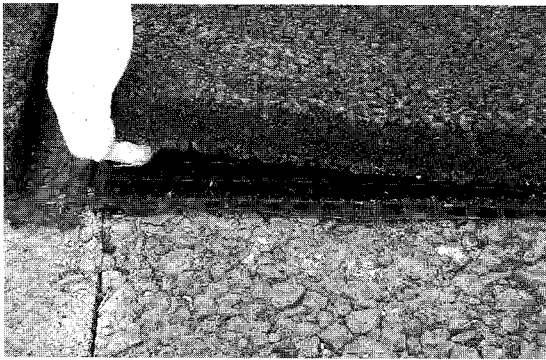
그림 3. Glass grid-1 부착면과 표층 분리모습
