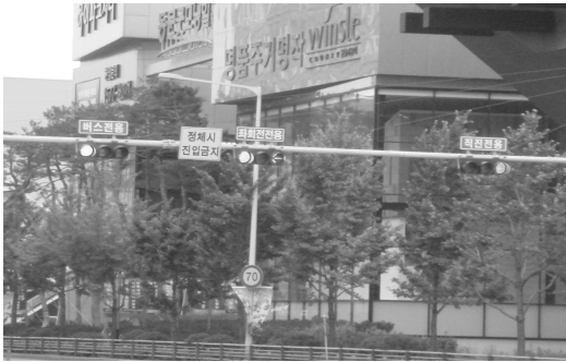
<그림 5> 중앙버스전용신호 운영현황 (고양시 백마주유소교차로) <Fig. 5> Median lane bus signal (Baekma intersection)
