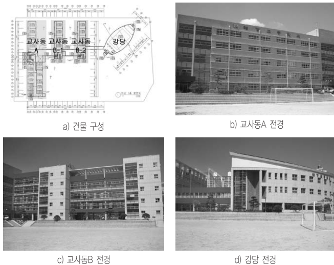
그림 3. 대상시설의 건물 구성 및 전경
