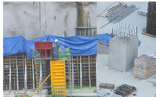
그림 14. 내화보강 고강도콘크리트 기둥부재 타설
