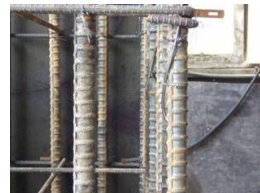
(e) 철근 조립
