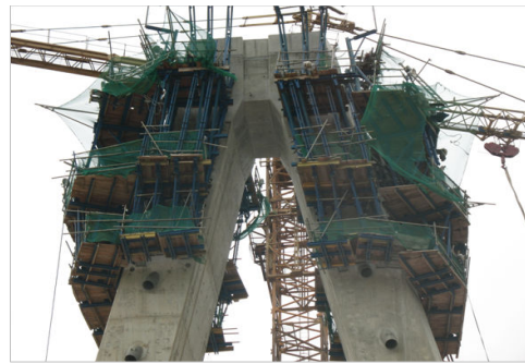
그림 18. 탑정부 프리캐스트 시공 모습
