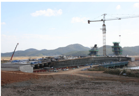
그림 14. 남창대교 보강형 시공 전경
