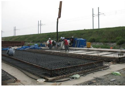
(a) 콘크리트 타설
