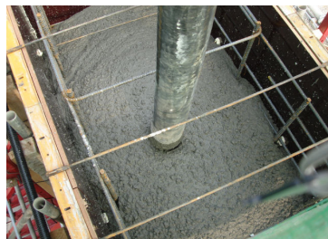
(e) 콘크리트 타설
