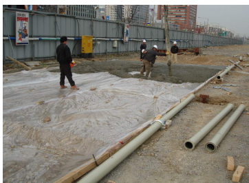
(a) 버림콘크리트 타설
