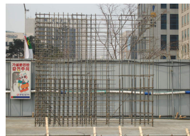
(c) 벽체 철근 설치
