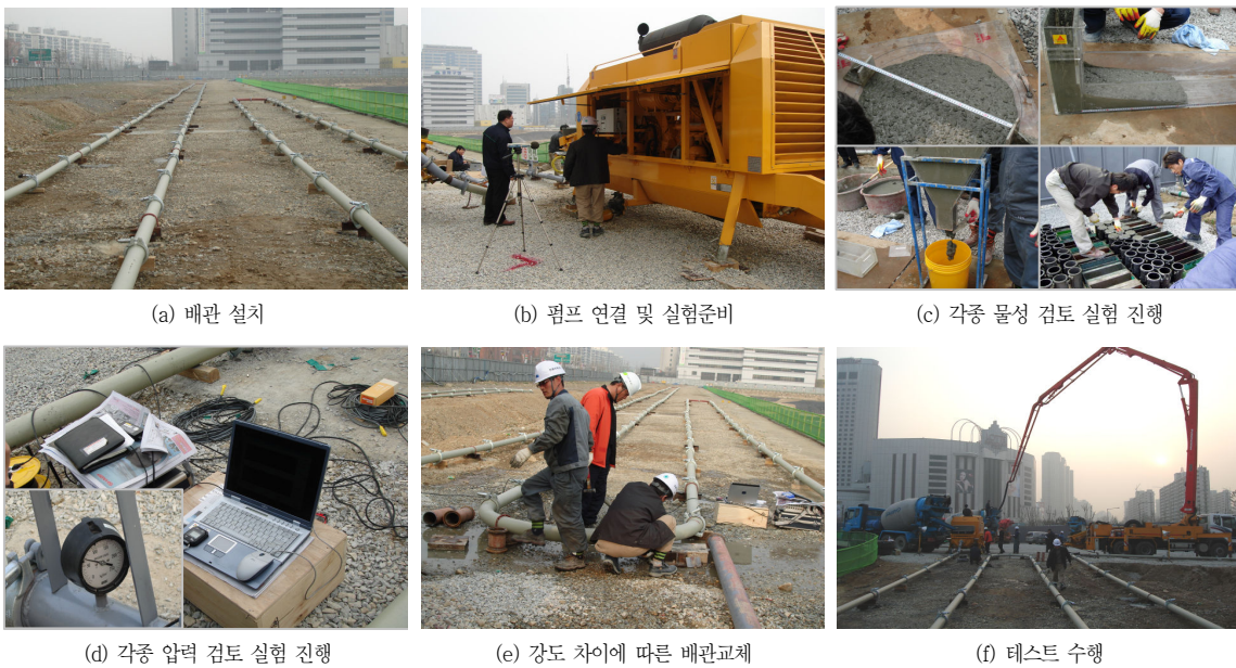
사진 4. 펌프압송성 테스트 수행 사진
