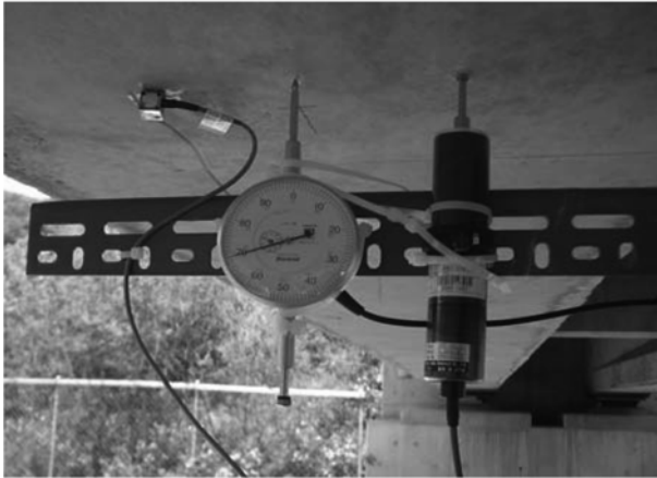
그림 5. 변위계 및 가속도계 설치
