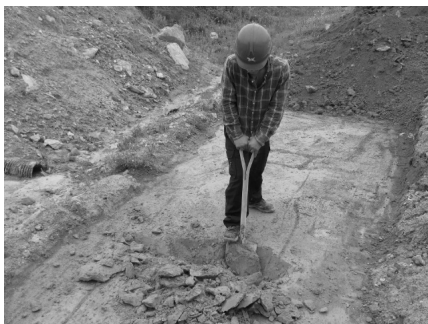
그림 10. 열 저항성 측정을 위한 인력굴착
