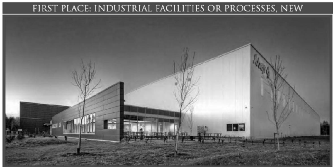
동부 캐나다에 위치한 Sobeys 창고는 냉동 창고부터의 열방출을 사무실 및 일반 공간에 난방 하는데 사용한다.
