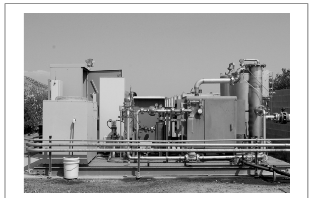
Fig. 2 매립지가스 연료화 전처리시스템(미국 LA Calabasas Landfill) (7,8)
