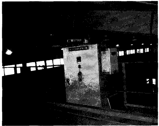
그림 11. 완성된 자동 제어함 외관 Fig. 11. Appearance of the automation control unit.
