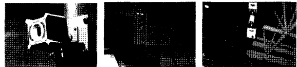
a) 열감지기 b) 열선식 주사형 화재 감지기 c) 광전식 분리형 연기 감지기
