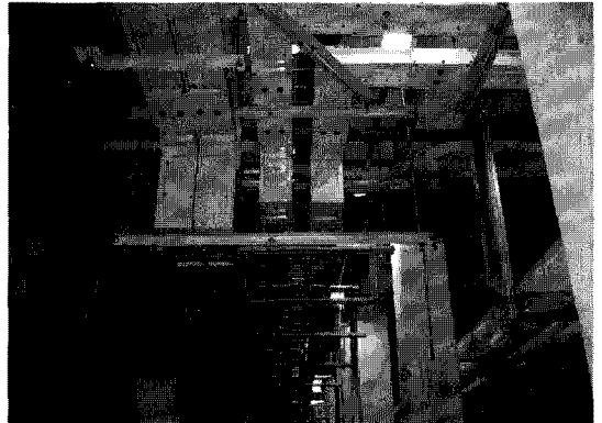
그림 3. Busduct 포설 사진.
