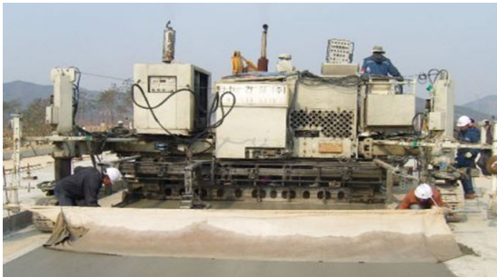
① 콘크리트 포설
