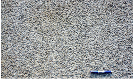
그림 1. 소입경 골재노출콘크리트포장의 표면조직
