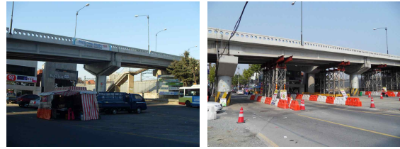
(a) 설치 전 (b) 설치 후
