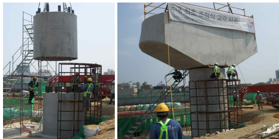
(a) 시공 전경(좌:기둥부 조립, 우:코펄부 조립)
