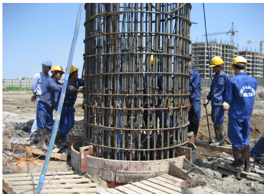
사진 2. 현장타설 말뚝 철근망 근입
