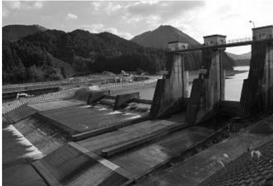
그림 3. 粟生 취입보에 어도식의 방류공 공사
