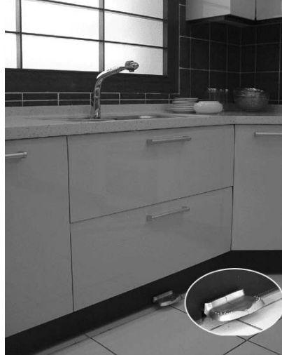
▲ 이지밸브의 발바리는 페달을 이용해 물을 들고 잠글 수 있게 해 사용자 편의성이 좋으며 단수 반응이 빨라 절수에 효과적이다.
