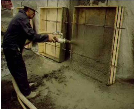
사진 2. 노즐맨 현장 시험 전경
