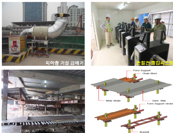
사진 2. 지하공사를 위한 가설 지지틀 시스템(BRD)
