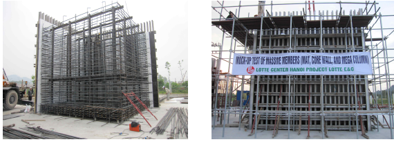
(a) 매트기초 철근배근과 거푸집 설치후 전경
