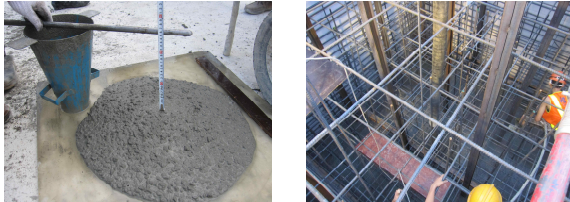
(b) 매트 콘크리트 물성 (c) 매트기초 타설전경 및 내부현황
