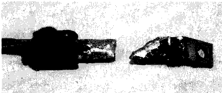
(d) Melting mark of the inner contactor of the circuit breaker
