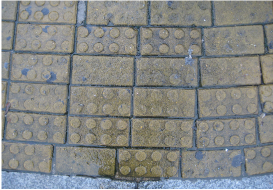
그림 12. 시각장애인 점자블록(일반콘크리트)의 마모
