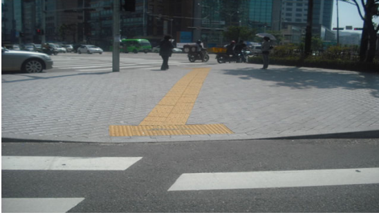
그림 1. 미끄럼 사고 발생 현장(횡단보도 턱나춤 구간)
