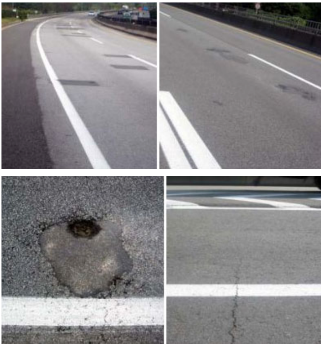
그림 1. 중부 및 호남고속도로에 아스팔트 덧씌우기 공법이 적용된 구간의 파손(김형배 외, 2008)
