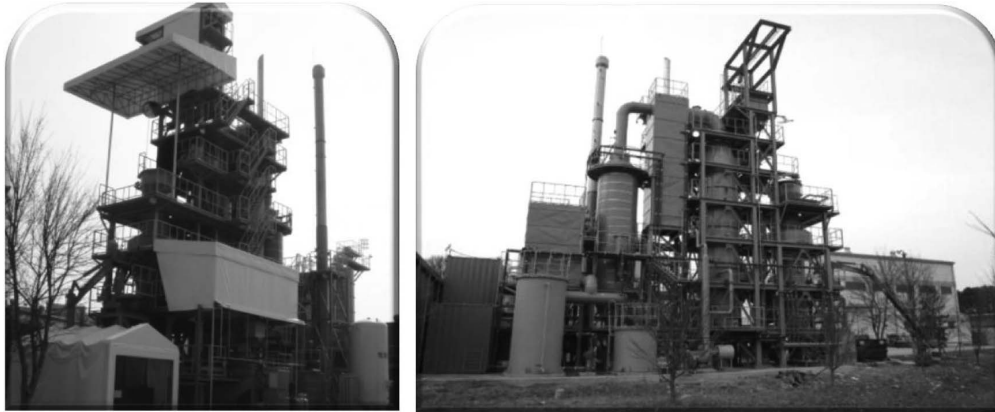
Fig. 7. 가스화 용융로 Pilot plant.
