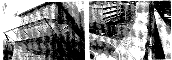
(a) 강관틀 낙하물 방지망(첫단에 설치) (b) 플라잉넷(첫단 이후 상부에 설치)
