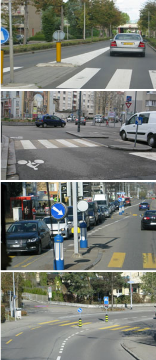
그림 2. 도시생활도로에서의 보행자 안전을 위한 간이 보행섬 설치 국외사례
