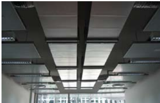
[그림 14] ECC 강의실 천장 현장 사진
