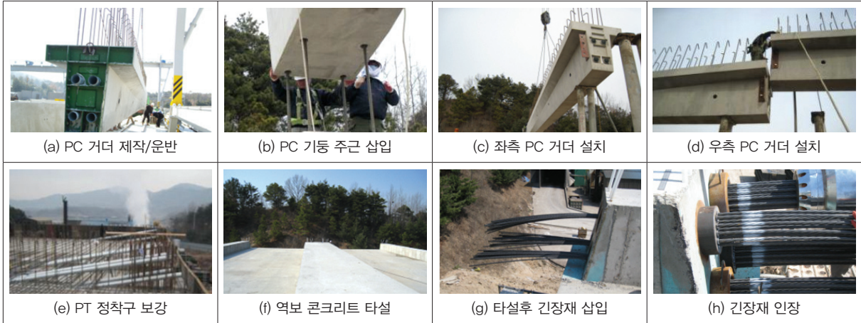
그림 9. 프리캐스트 포스트텐션 거더 시스템 시공 순서
