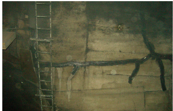
그림 4. 기존 터널 라이닝 균열조사 결과
