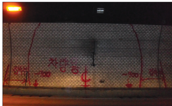
그림 5. 기존 터널 차량용 피난갱 설치위치
