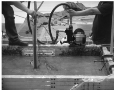
(a) 지반 관입 후 플러싱 처리
