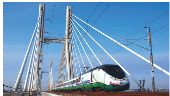
사진 6. Po River Bridge
