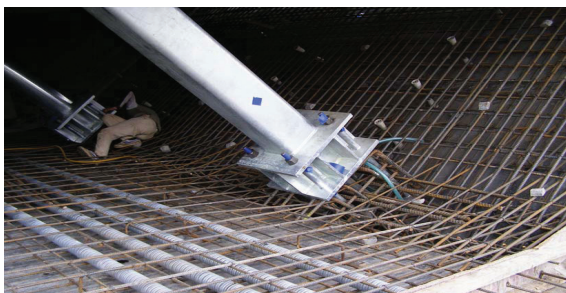
사진 3. Bai Chay교의 스트럿과 박스거더 접합부
