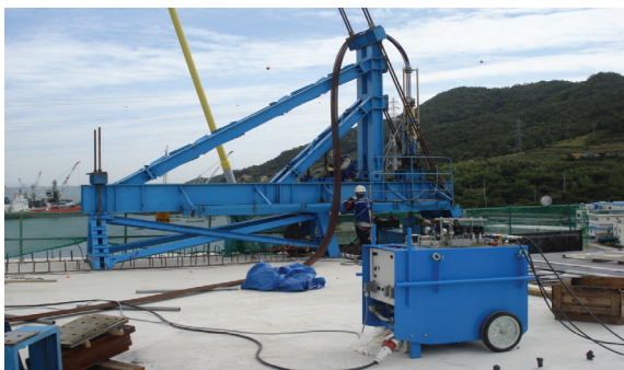
사진 7. Lifting Framse(F/T 2 nd Heavy Lifting 시)
