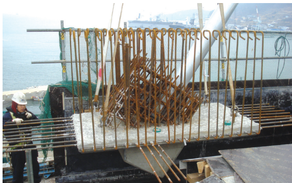
사진 10. Stay Blister 설치
