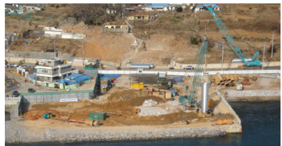
사진 2. PY02 현장타설 말뚝 시공전경(2008. 01)
