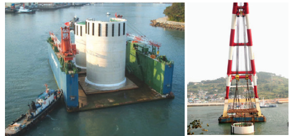
(a) 우물통 제작 (Floating Dock) (b) Floating Crane을 이용한 거치
