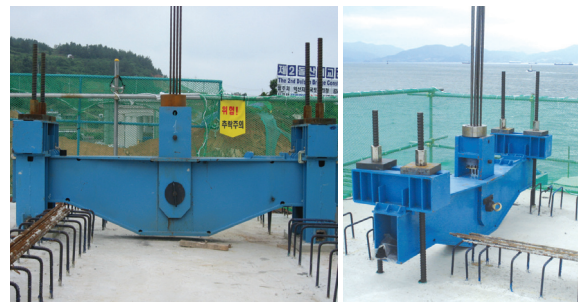
사진 9. 주두부에 설치된 Lifting Beam
