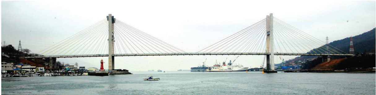
사진 11. 제2돌산대교 시공완료 후 전경(2011.04, 부대공 제외)
