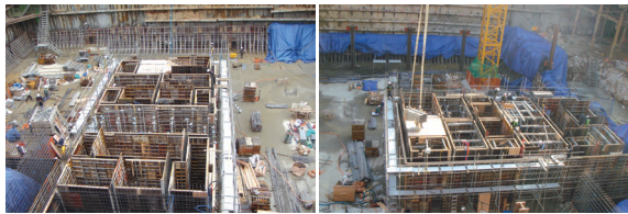
(a) 합벽구간 V/H 분리타설 (b) 코어 선시공 작업
