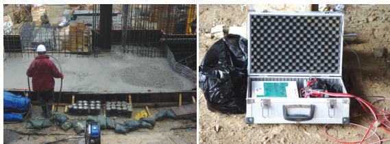
(b) 콘크리트 타설
