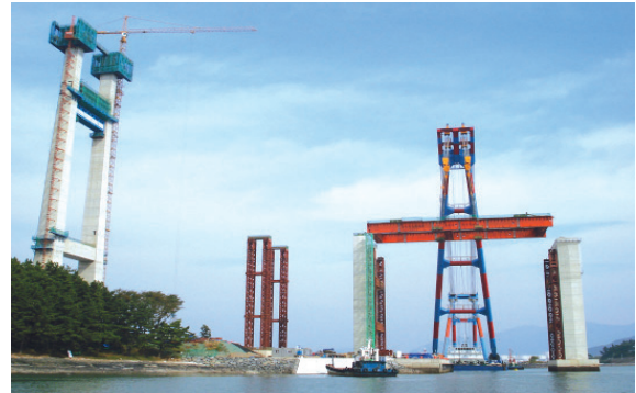
(a) 임시지지 거더 설치
