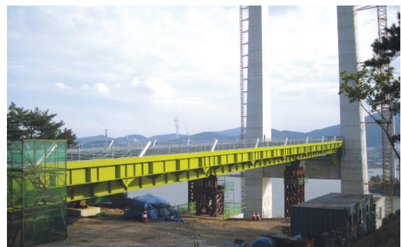
(b) 종점부 측경간 압출 완료
