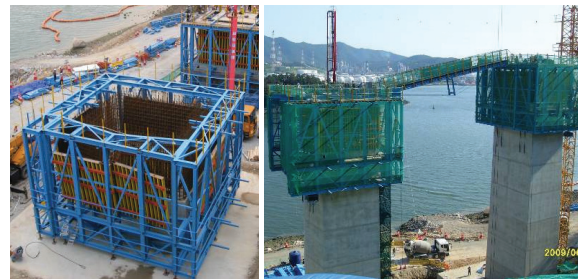
사진 1. 기계식 인상 시스템을 적용한 일체형 프레임 형식의 ACS
