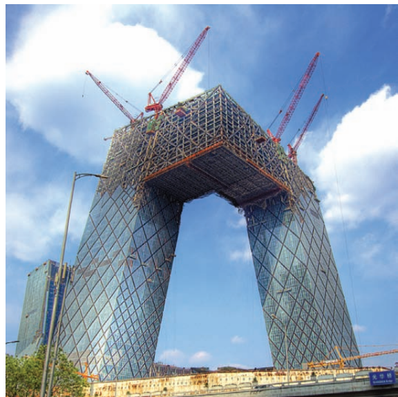
사진 1. 베이징 CCTV타워의 캔틸레버 층 시공 중 모습 2)
