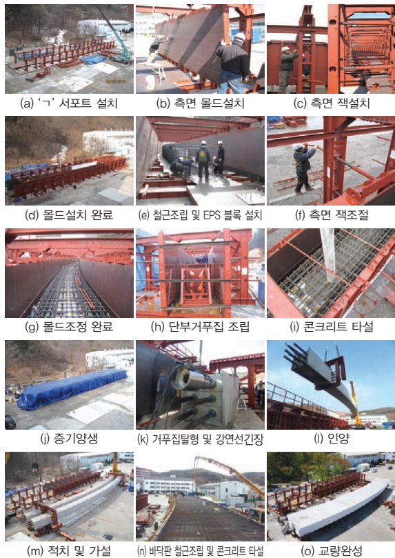
사진 2. 프리캐스트 곡선 PSC 박스 거더 시공순서
