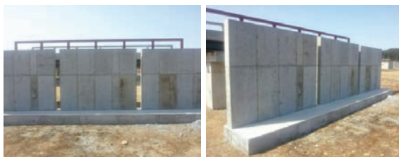
사진 5. 시공 장비의 성능평가를 위한 콘크리트 구조물
