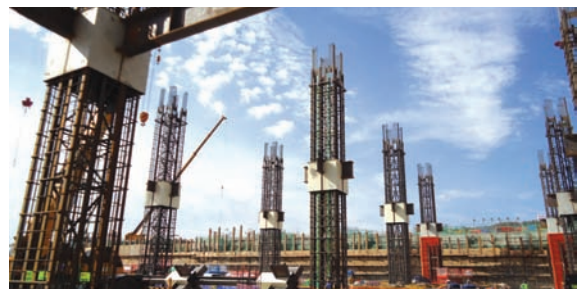
(b) 공사현장 전경
