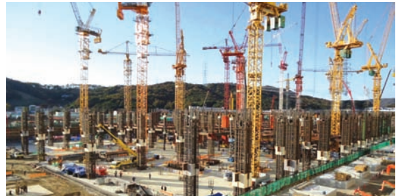
(a) 공사현장 전경
