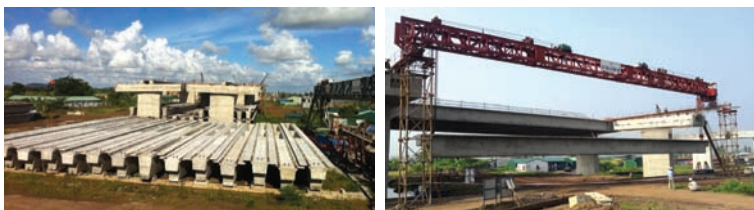
(a) Super-T 거더 제작 및 야적 (b) Super-T 거더 가설
