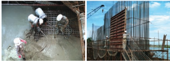
(c) 기초 콘크리트 타설 (d) 교각 철근 조립 및 거푸집 설치
