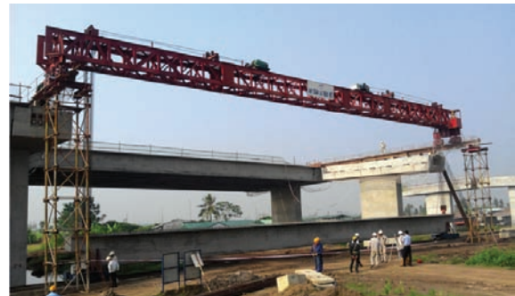
사진 6. Super-T 겐트리크레인 하중재하시험
