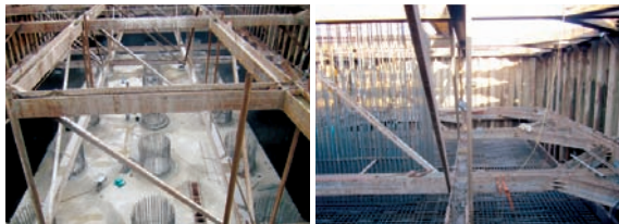
(a) 말뚝 두부 정리 및 기초 거푸집 설치 (b) 기초 철근 조립
