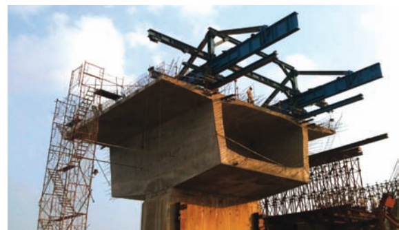
사진 4. Pier 8 주두부 시공 완료 및 폼트레블러(F/T) 설치
