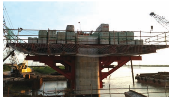
사진 7. F.C.M 구간 Pier 11, 주두부 브라켓 하중재하시험
