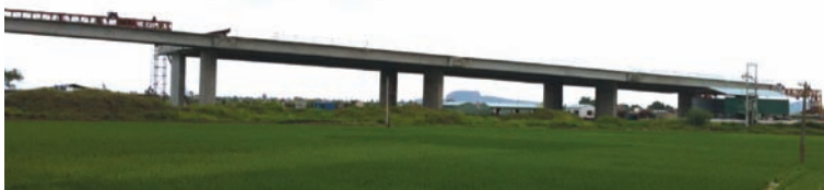
(c) Super-T 구간 전경 사진 1. 탄안교 Super-T 거더 구간
