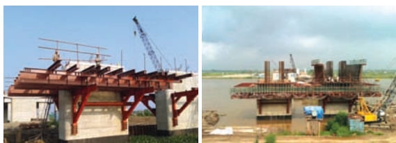
(g) 주두부 브라켓 설치 (h) 주두부 폼 설치 및 철근 배근
