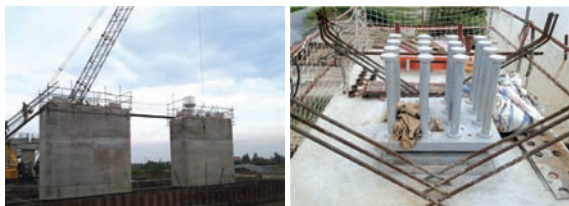
(e) 교각 시공 완료 (f) 포트받침 및 스토퍼 설치
