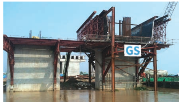
사진 3. Pier 8 주두부 시공을 위한 거푸집 설치
