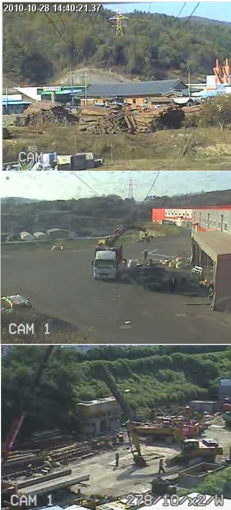
〈그림 14〉 현장경보기 설치 (Fig. 14) Install of on-site alarm unit
